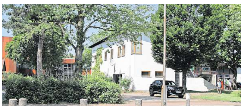
Links die Oberschule, rechts der Jugendpavillon – in beiden Gebäuden gibt es Platzmangel.
